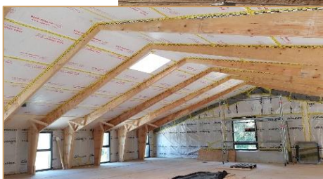
160 m 2 FBT PR 170 mm dans l'ossature bois habillant façades et pignons.
