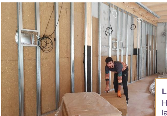
Au rez-de-chaussée, 120 m 2 FBT PR 145 mm.
