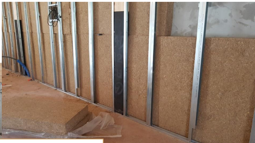
Au rez-de-chaussée, 120 m 2 FBT PR 145 mm.
